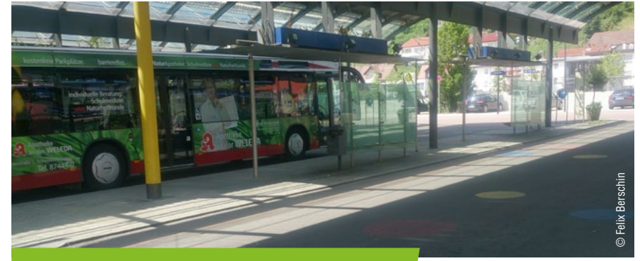
Busbahnhof in Schwäbisch Gmünd ohne Busbahnsteige.
